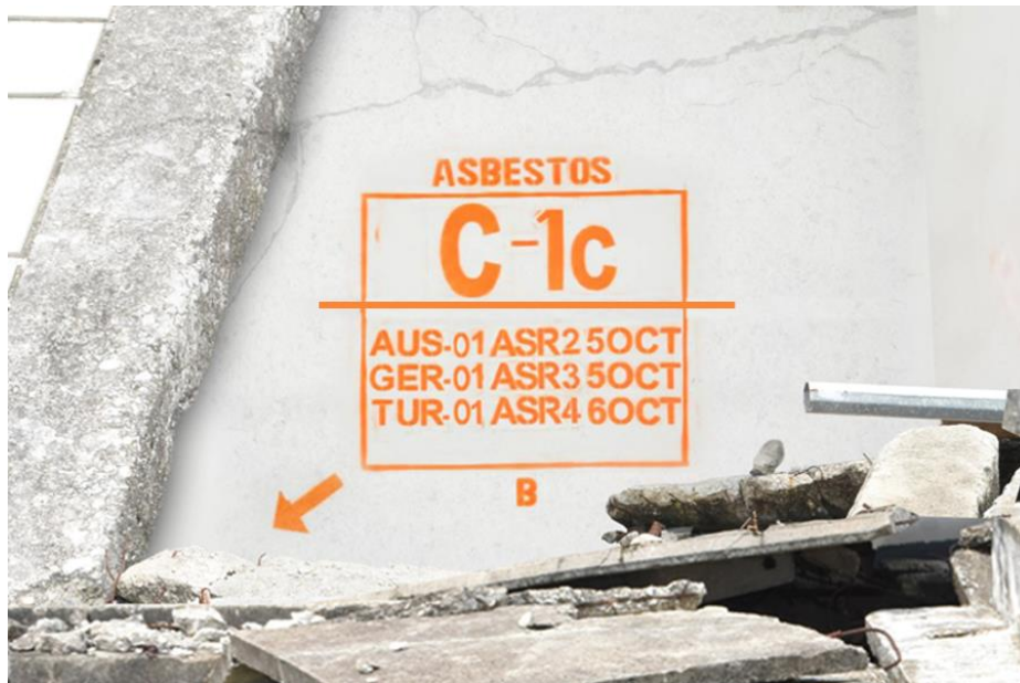
Figura 23 : Turquía 01 habiendo completado ASR 4 Full SAR en el lugar de trabajo, ha determinado que no se requieren más trabajos en este lugar de trabajo.
